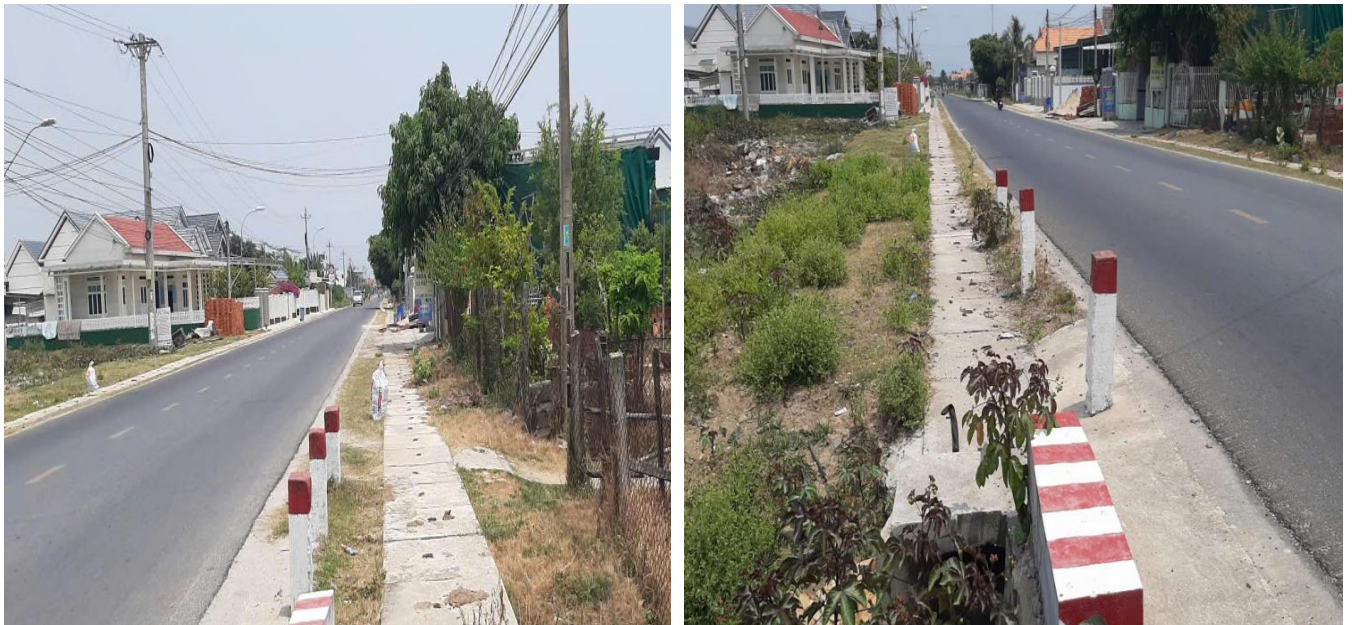
Hệ thống mương nắp đan trên đường DT652DB
