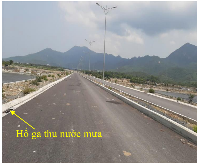
Thoát nước mưa trên đường DT652BD
