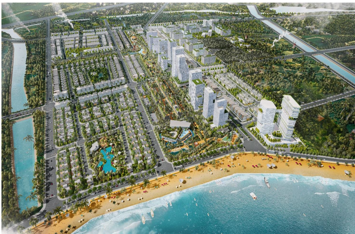
Hình 1.18. Góc nhìn tổng thể KDC Ninh Thủy từ phía biển
