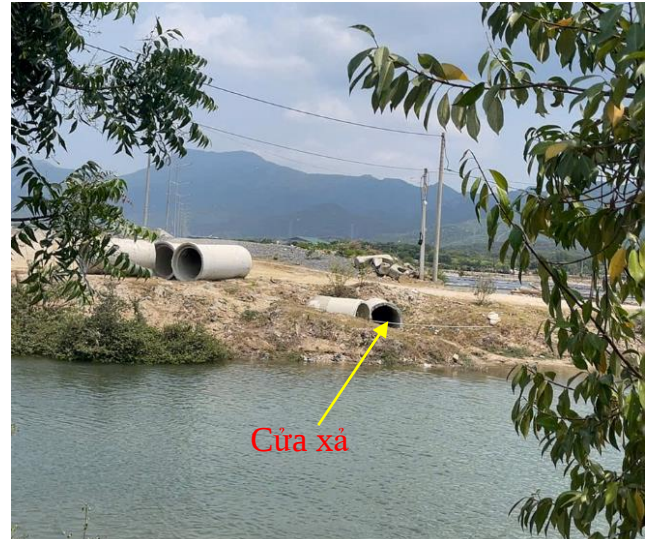
Cửa xả nước mưa cuối đường DT652BD
